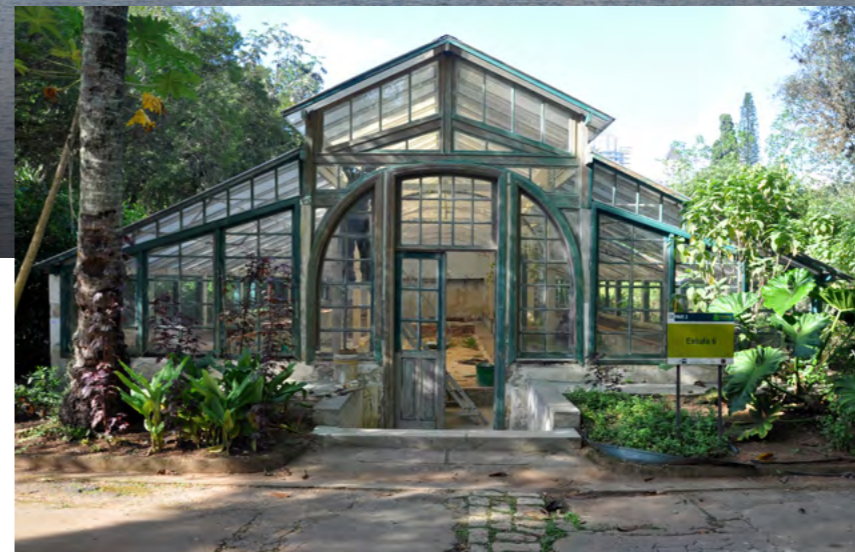
Parque Ibirapuera é o grande atrativo do primeiro lote de parques municipais no modelo de concessão
