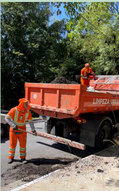
Limpeza de bueiros
